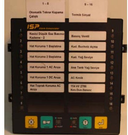
Şekil3-Etiketi şekildeki gibi takınız
